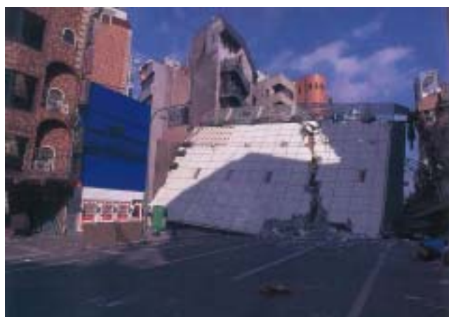
建物倒壊による道路閉塞（阪神・淡路大震災）
