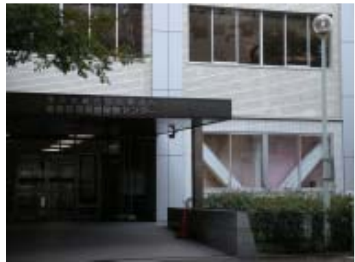
都立庁舎の改修事例
