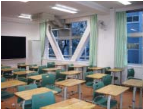
都立学校の改修事例
