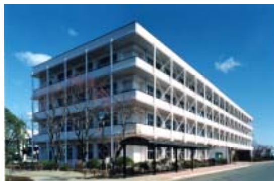
私立学校で耐震改修を実施した例 1
