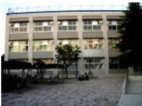
都立施設で耐震改修を実施した例
