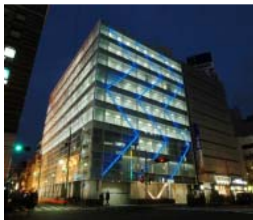
補強に用いた鉄骨をライトアップし、耐震改修したことを積極的に見せるデザインの事例
